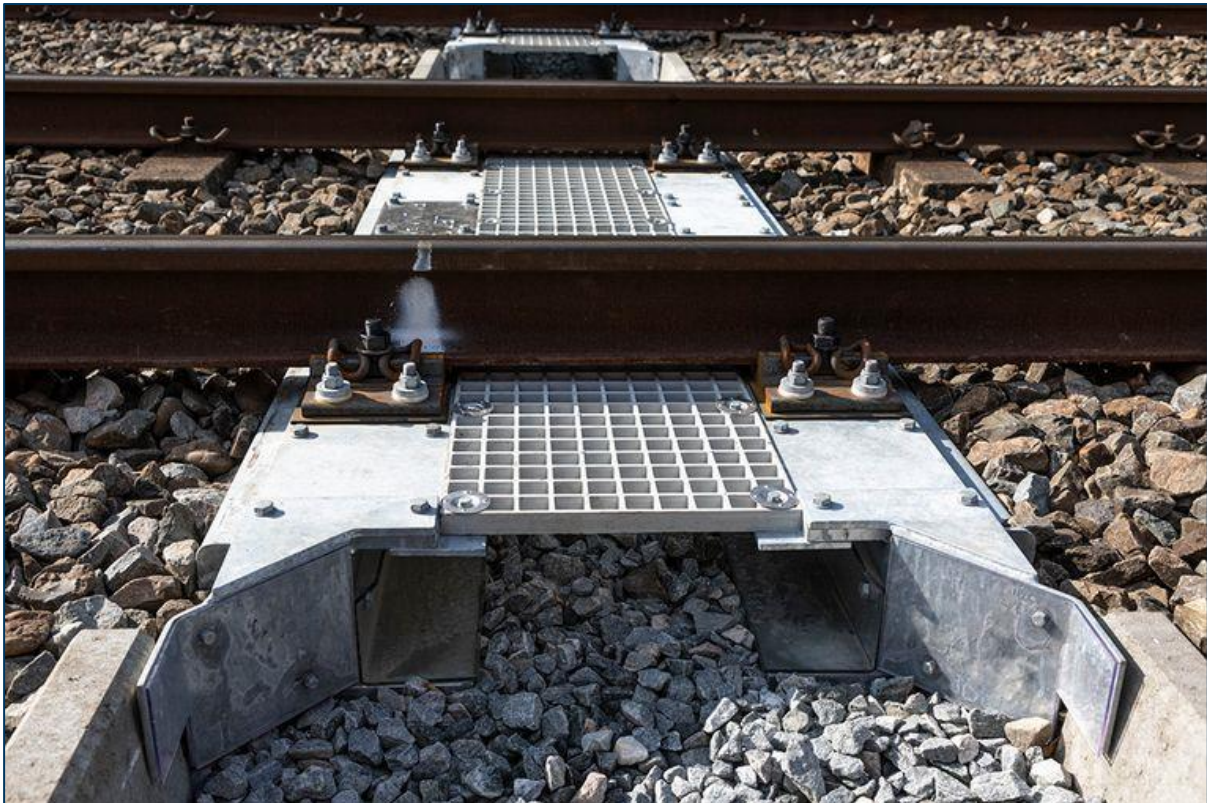
Figuur 4.1: Voorbeeld van dwarsligger faunapassage (DFP) voor amfibieën en reptielen. Uit onderzoek blijkt dat kleine zoogdieren en dassen ook gebruik maken van deze passage (al is deze naar verwachting minder geschikt dan de 'standaard' passage die voor das gebruikt wordt).
