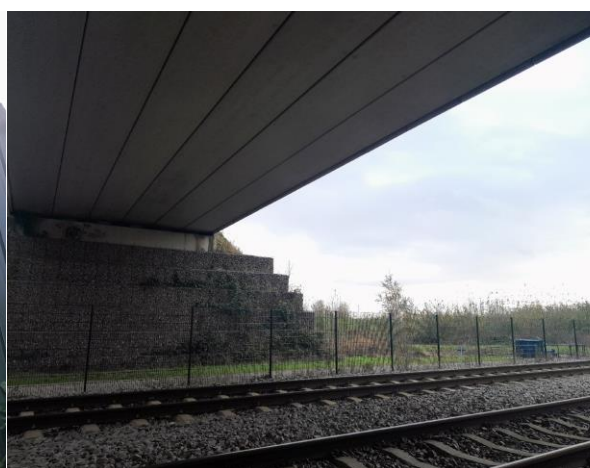
Figuur 3.17: Viaduct met aan de onderzijde spleten die geschikt zijn voor vleermuizen.
