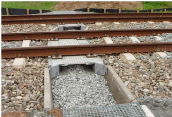
Figuur 3.1. Verschillende vormen van faunapassages. Met van links naar rechts en van boven naar beneden voorbeelden: holle buis constructie; een looprichel; Dwarssligger FaunaPassage; en groenstrook parallel aan spoor.
