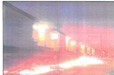
Figuur: Het bijlijpen van spoorstaven.
