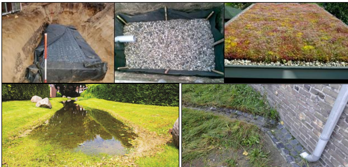
Figuur 13: Voorbeelden infiltratievoorzieningen
