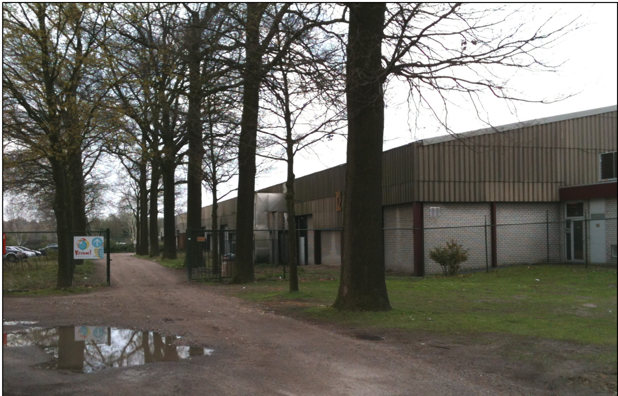
Figuur 5 Foto van de noordelijke zijgevel van de tennishal.
