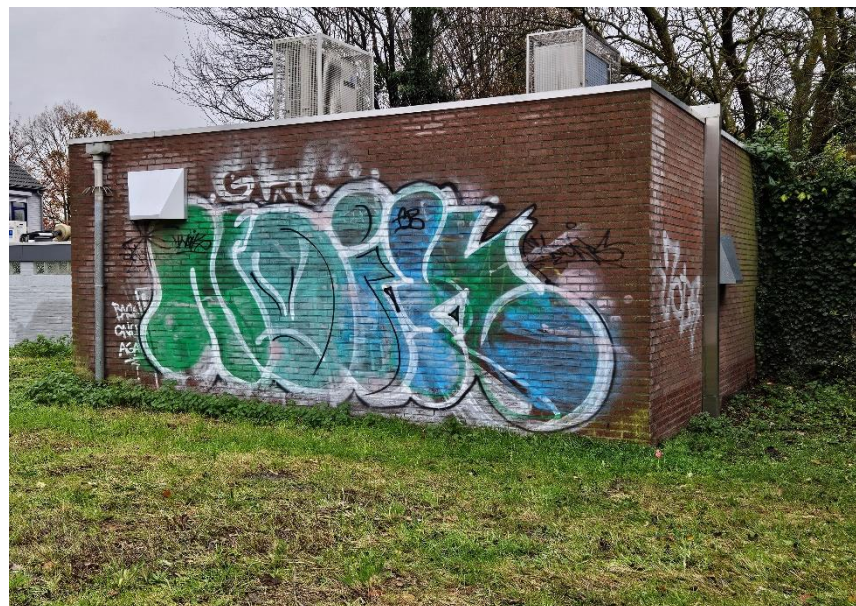
Figuur 8: Elektriciteitshuisje binnen plangebied
