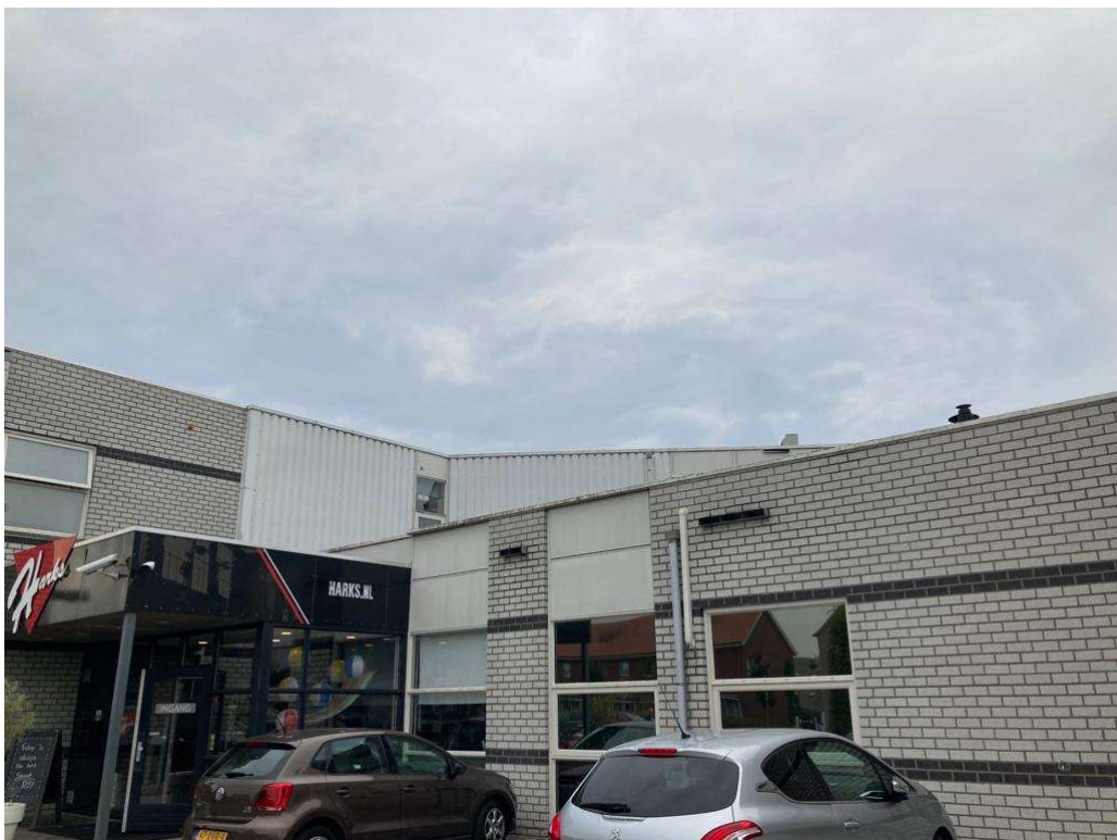
• Afbeelding 8: Fragment voorgevel te slopen gebouw
