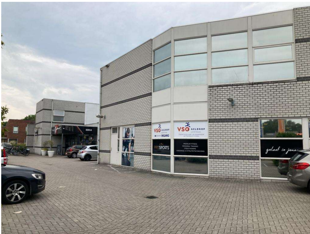
• Afbeelding 3: Voorgevel te slopen pand met daarvoor bestrating
