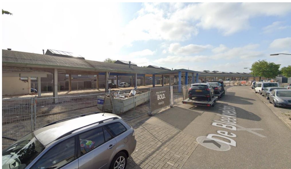
Figuur 6: Aanzicht van De Bleekvelden 1-20, woningen in aanbouw
