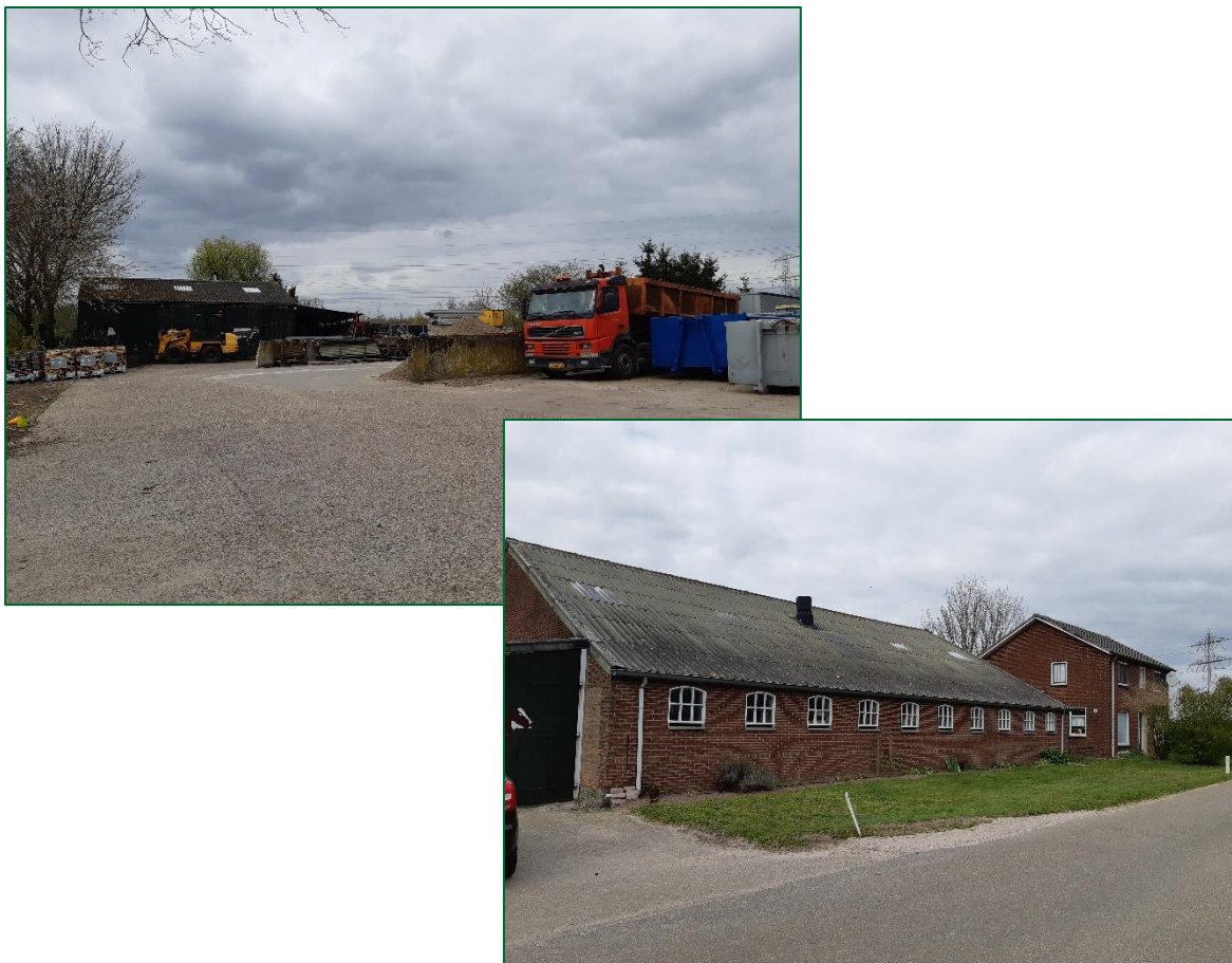
Afbeelding 8, 9: Huidige situatie achterterrein met te verplaatsen werkplaats en aanzicht bedrijfsgebouw en woning vanaf het Heiderschoor
