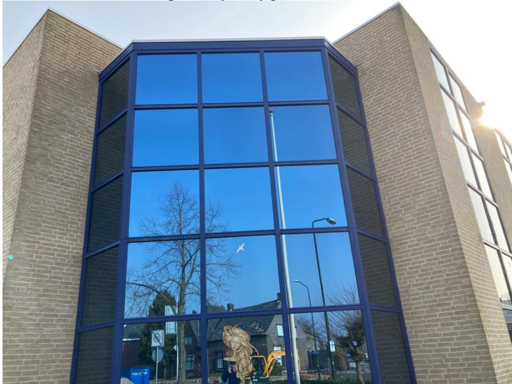
• Afbeelding 4: buitenzijde bedrijfsgebouw
