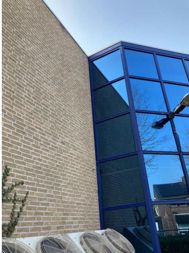
• Afbeelding 8: buitenzijde bedrijfsgebouw
