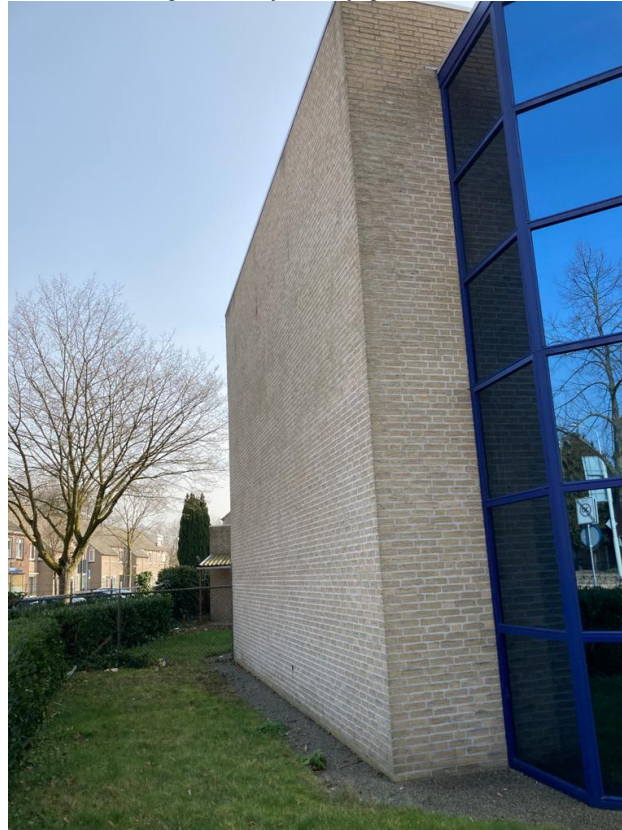
• Afbeelding 3: buitenzijde bedrijfsgebouw
