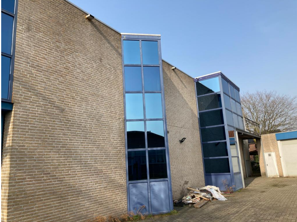
• Afbeelding 6: buitenzijde bedrijfsgebouw
