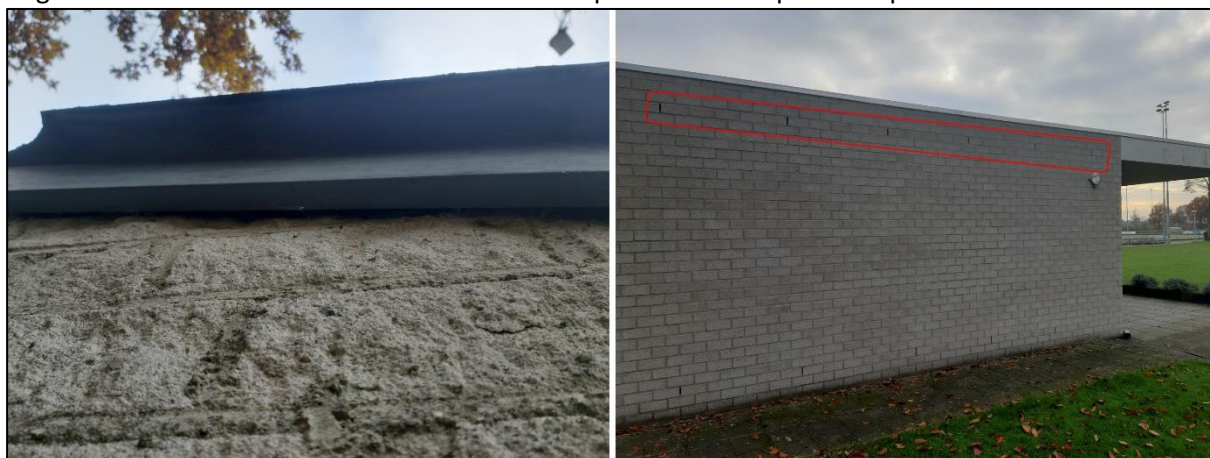
Figuur 8: Voorbeelden van mogelijke verblijfplaatsen/ingangen voor gewone dwergvleermuis: ruimtes achter de daklijst van de schuur en stootvoegen in de muur van het gebouw van de gildevereniging.
