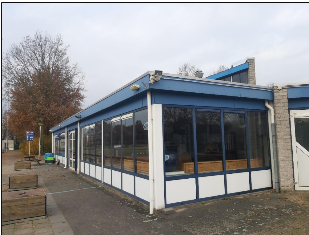
Figuur 5: Het gebouw van de hockeyvereniging. Verblijfplaatsen van vleermuizen zijn hier niet uit te sluiten.
