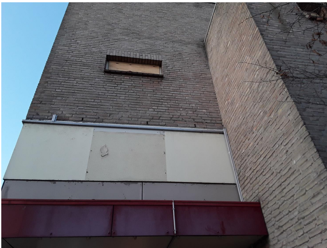
Figuur 4 Open stootvoegen met toegang tot de spouwmuur, die geschikt is bevonden om als verblijfplaats voor vleermuizen dienst te doen.
