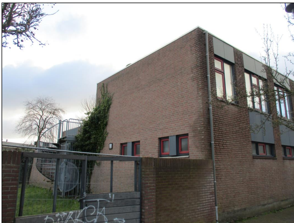
Figuur 2 De achterzijde van de voormalige brandweerkazerne.
