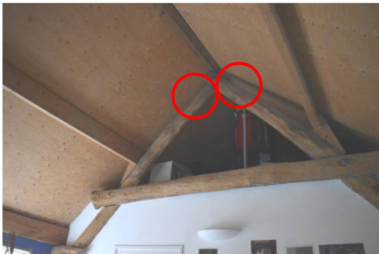
Houten schaarspant met twee horizontale balken op verdieping linker woning met telmerk III (rood omcirkeld).
