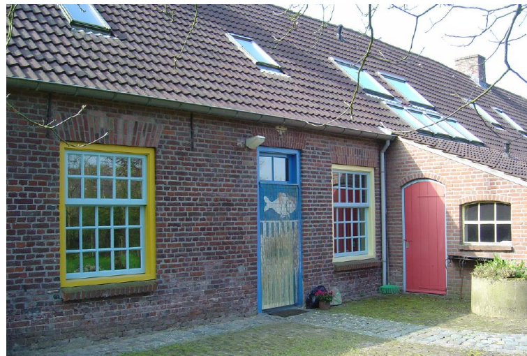
Foto linkerzijde van achtergevel met aanbouw uit 2005. Bron: Verkregen van eigenaar.
