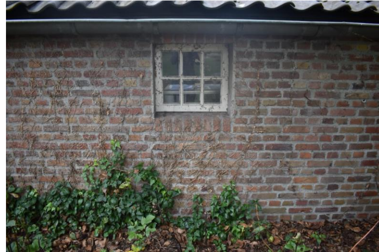
Betonnen zesruits stalraam midden uit 1983.
