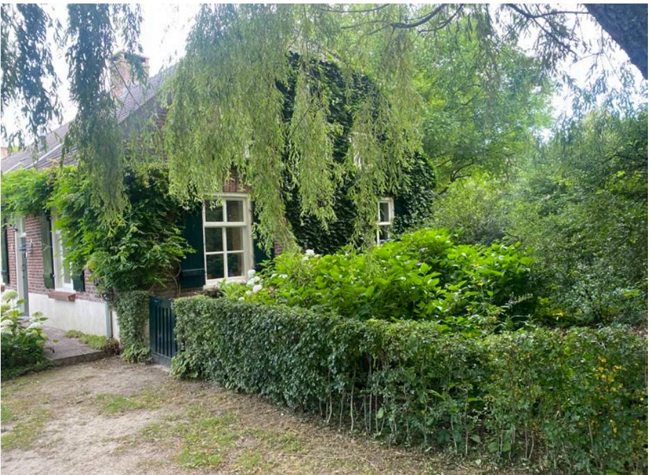
Bestaande tuin kopgevel
