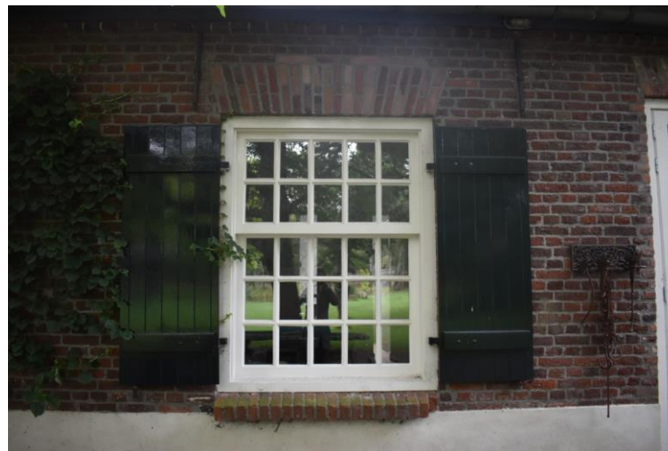
Vernieuwd venster met bovenlicht.
