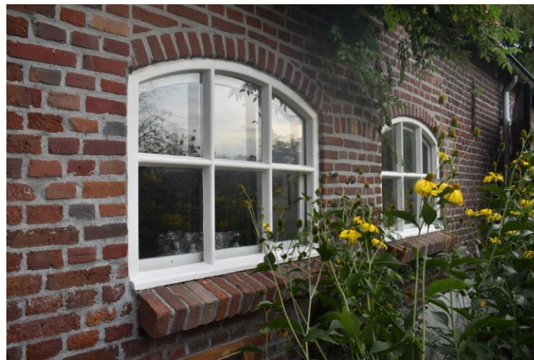
Betonnen zesruits stalvensters met bakstenen dorpel.
