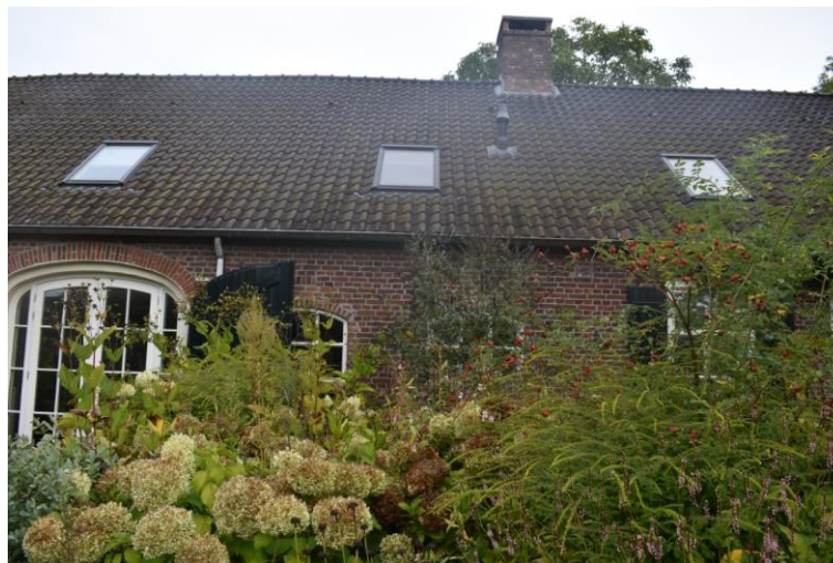
Twee zesruits betonvensters.
