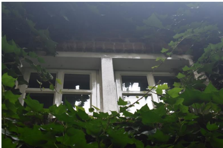
Rechter venster op verdieping.
