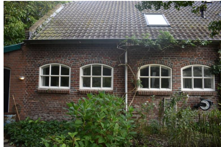
Vier betonnen zesruits stalvensters.
