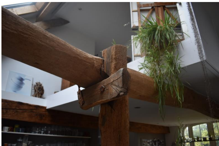
Houten constructieonderdelen begane grond rechter woning.
