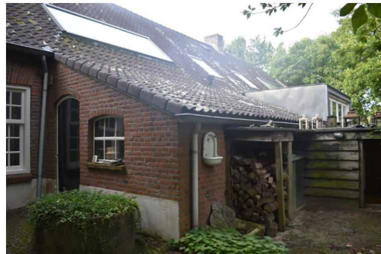
Aanbouw met opening.
