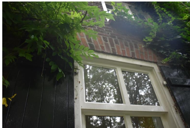
Rechter venster in rechtzijgevel.
