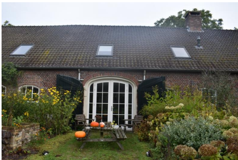
Dubbele deuopening die in 1979 is toegevoegd.
