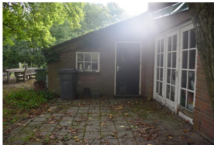
Linkerzijgevel van uitbouw uit 1980.
