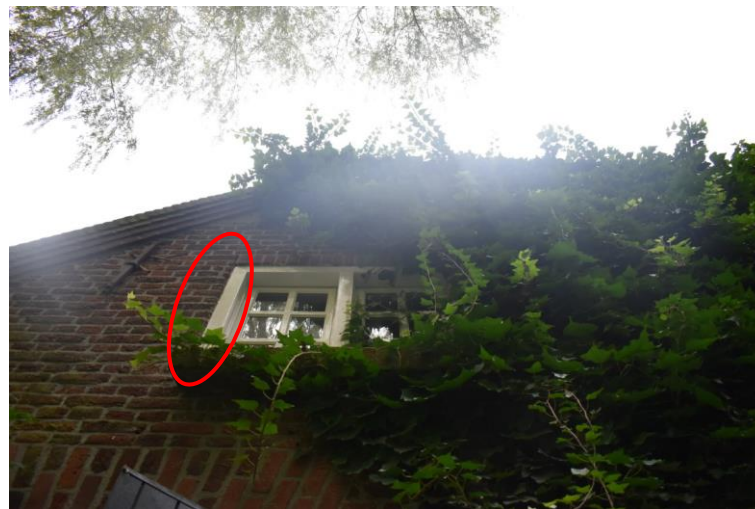
Linker venster op verdieping.
