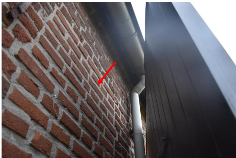
De rode pijl wijst de dichtgemetselde opening aan.
