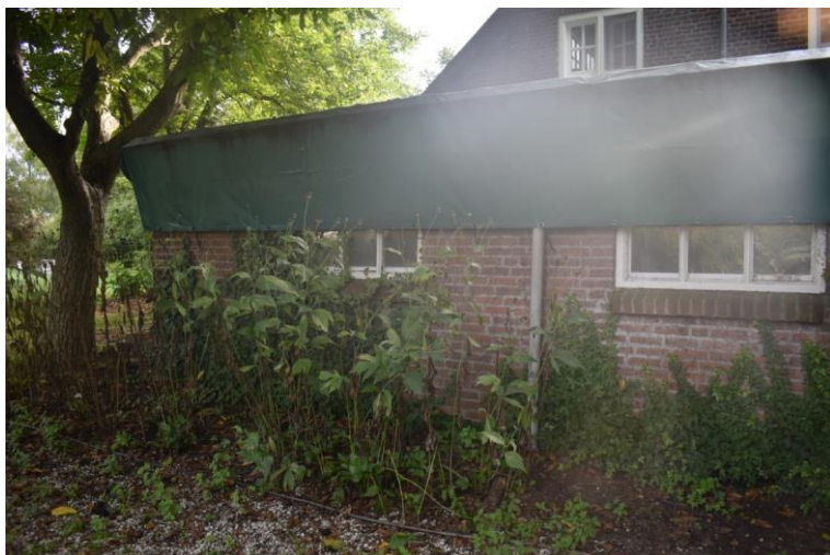
Linkerzijgevel met twee betonnen zesruits stalvensters.
