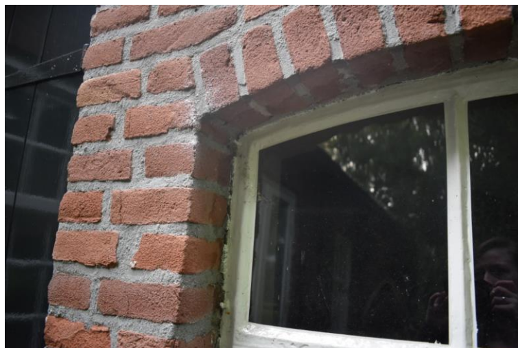
Detail ijzeren stalvenster.
