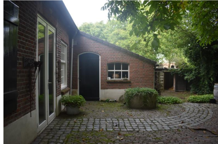
Rechtergevel aanbouw aan de achterzijde.
