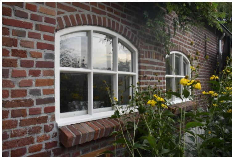
Betonnen zesruits stalvensters met bakstenen dorpel.
