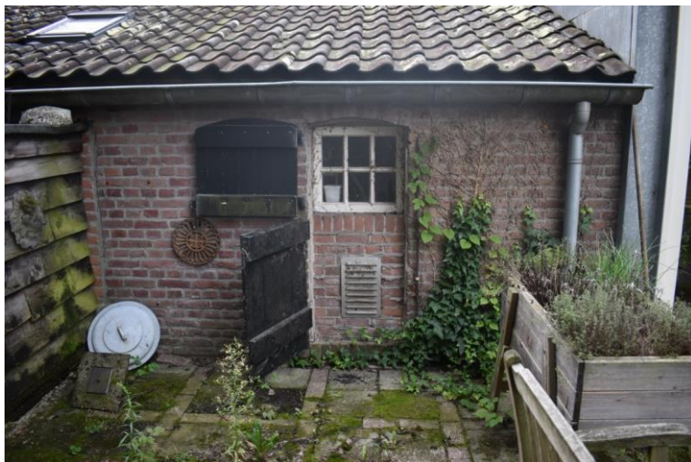
Betonnen zesruits stalraam links.
