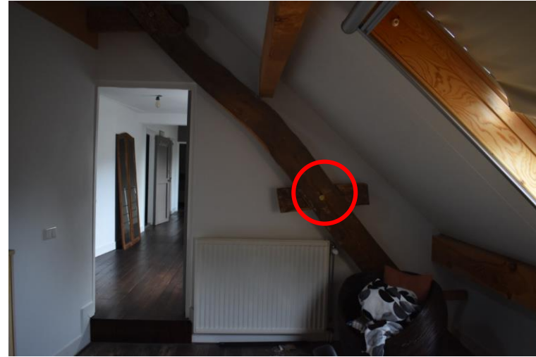
Houten spant links met moerboutverbinding (rood omcirkeld) verdieping rechter woning.
