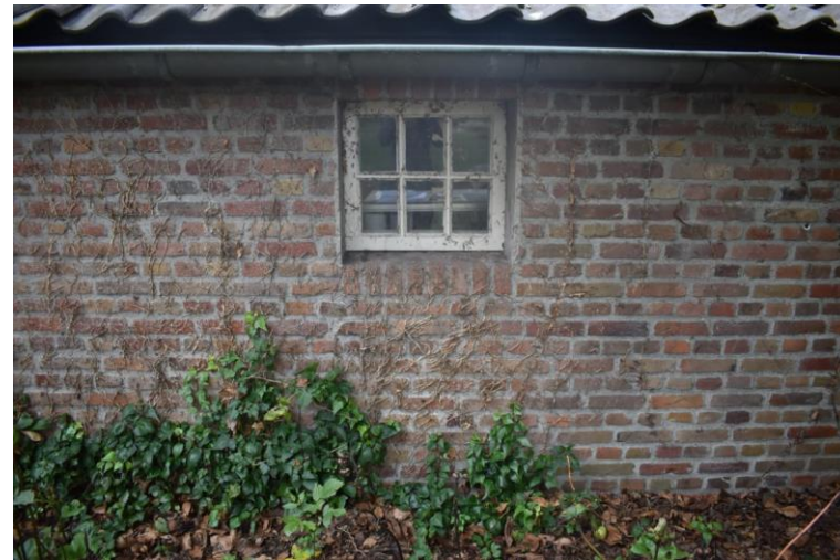
Betonnen zesruits stalraam midden uit 1983.
