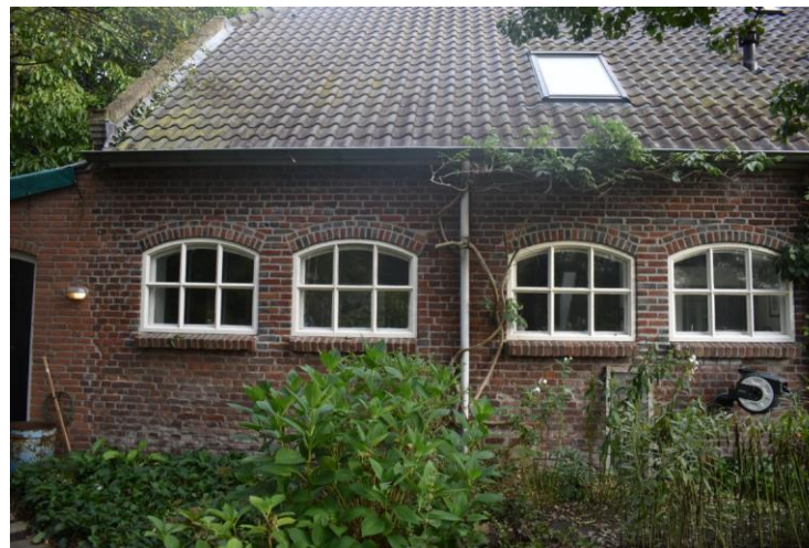
Vier betonnen zesruits stalvensters.
