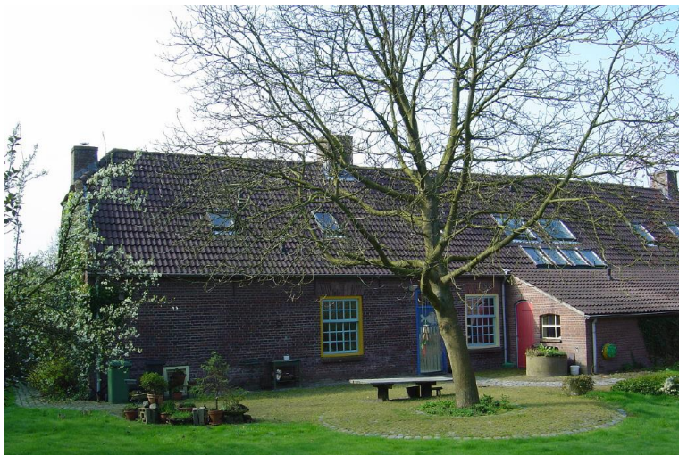
Foto linkerzijde van de achtergevel uit 2005. Bron: Verkregen van eigenaar.
