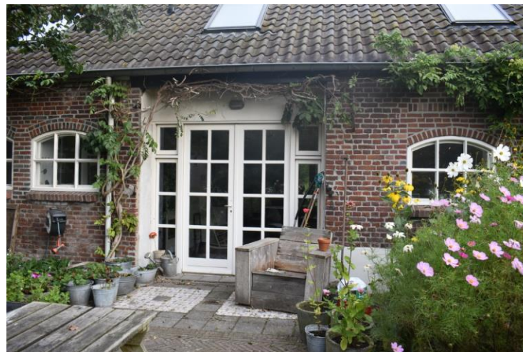
Vernieuwde dubbele deur met zijlichten uit de vierde kwart van de twintigste eeuw.
