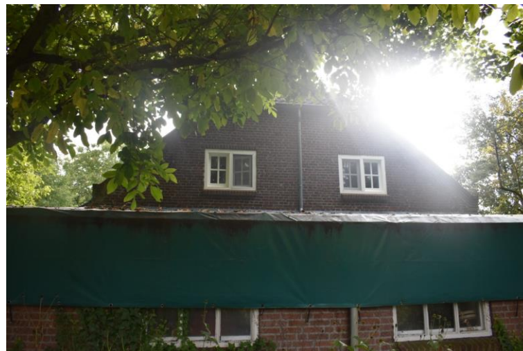
Verdieping linkerzijgevel met twee later geplaatste vensters.
