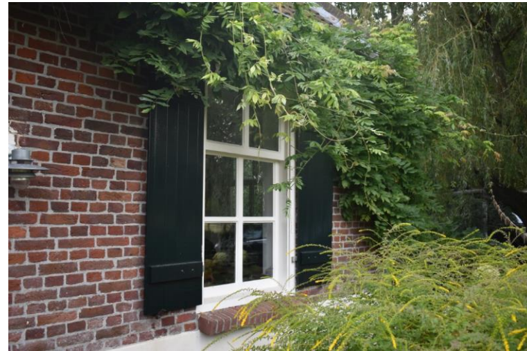
Houten vierruits raam met tweeruits bovenlicht.
