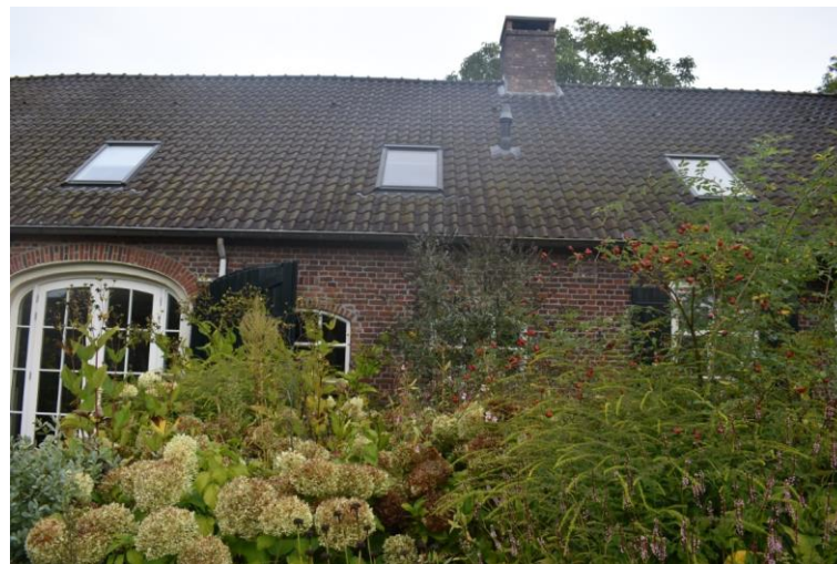
Twee zesruits betonvensters.
