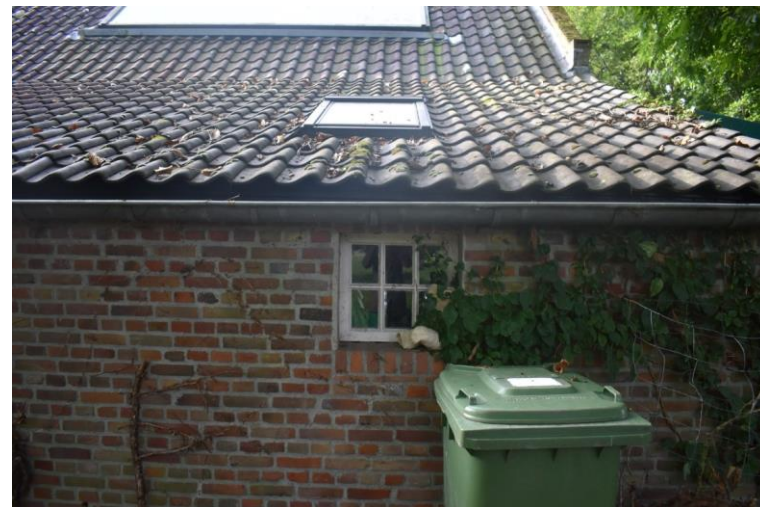
Betonnen zesruits stalraam rechts uit 1983.
