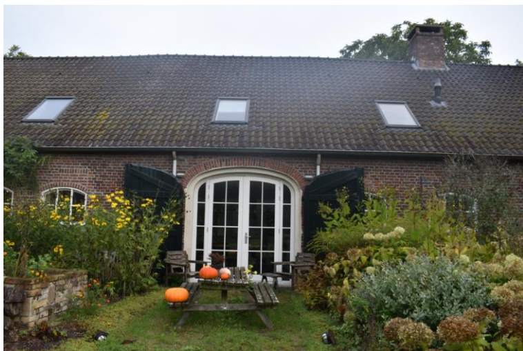
Dubbele deuopening die in 1979 is toegevoegd.
