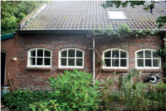
betonnen zesruits stal vensters
