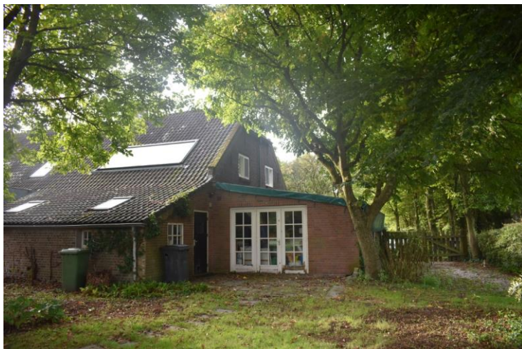
Dubbele deur met zijlicht onder rollaag.
