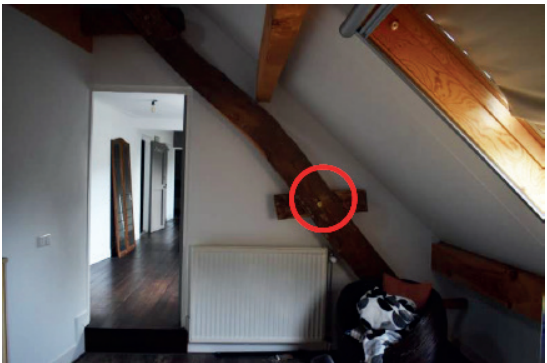
houten spanten met oude telmerken
