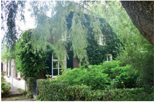
bestaande kopgevel woongedeelte
