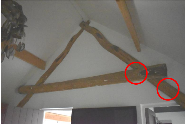
Houten schaarspant met twee horizontale balken met telmerk IV (rood omcirkeld) rechterzijde verdieping rechter woning.
