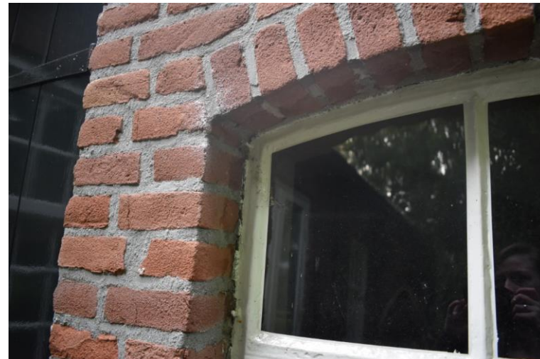
Detail ijzeren stalvenster.
