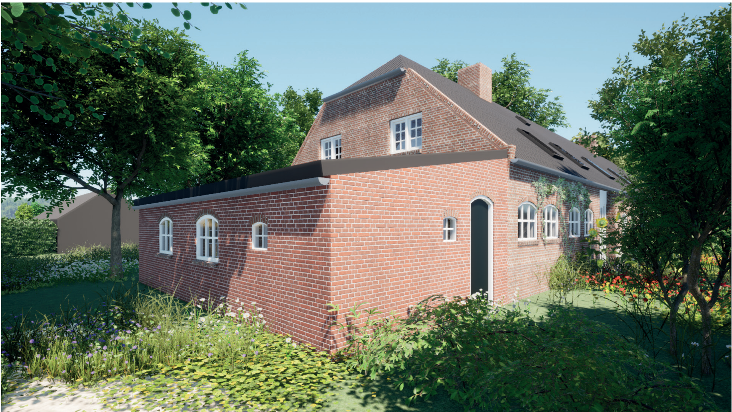
Bestaande zuid-west gevelaanzicht
