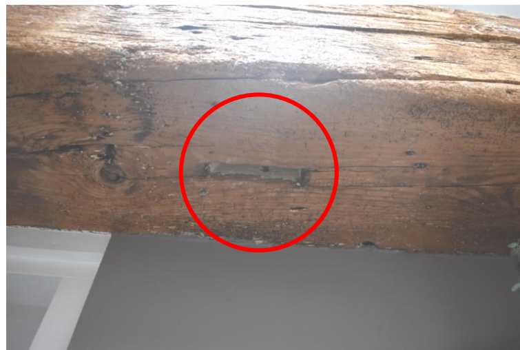
Sleuf in moerbalk (rood omcirkeld) begane grond rechter woning.
