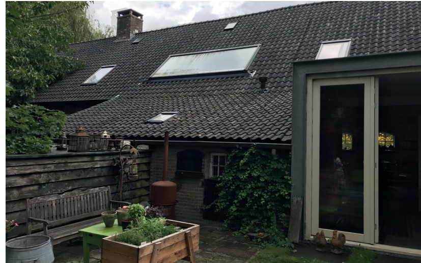
Achtergevel Gijzenrooi 3A
