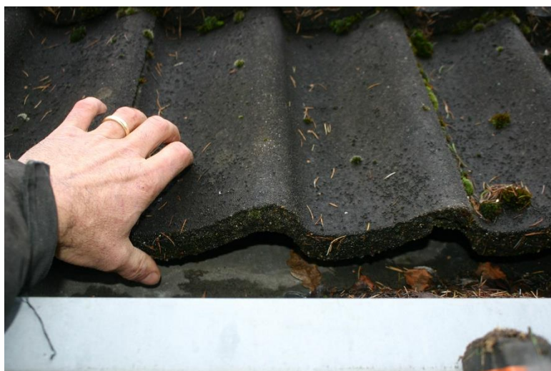
Figuur 4.4.1. Onder de onderste rij dakpannen van het woonhuis is geen ruimte voor vogels.
