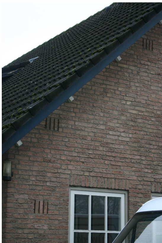
Figuur 4.4.2. Enkele gevels bevatten ventilatiesleuven die toegang geven tot de spouw.
