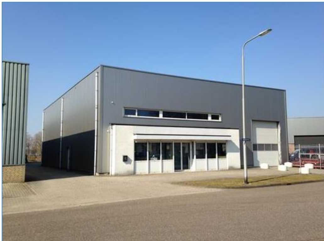
Figuur 4: Bedrijfsgebouw Ambachtweg 57
