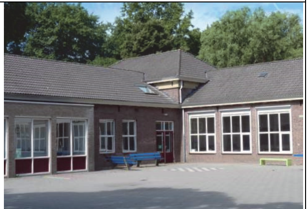
Schoolgebouw op plangebied 2a, met open stootvoegen op diverse plaatsen, en openingen in het dak, die geschikt zijn voor vleermuizen.
