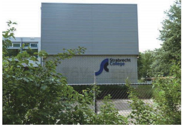
Overzicht pleinruimte en bebouwing college. Foto genomen aan westzijde gebouw
