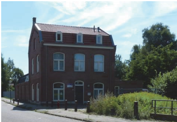
Plangebied 15, Voorzijde jongerencentrum, met rechts op de voorgrond de brug over de Kleine Dommel. Foto genomen richting het oosten
