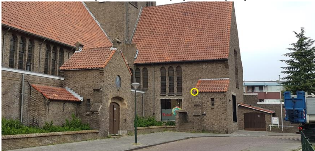
Foto 12. Nestlocatie van gierzwaluw onder het dakje bij het kinderdagverblijf
