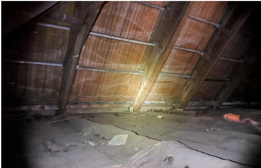
Foto 4. Situatie op de zolder van de kerktoren
