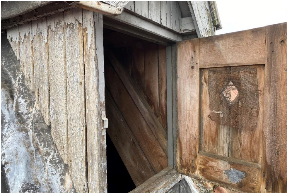
Foto 6. Luik naar de zolder van de kerktoeren met bestaande in- en uitvliegopening (voor de foto is de deur kort opengezet, deze is normaal dicht)
