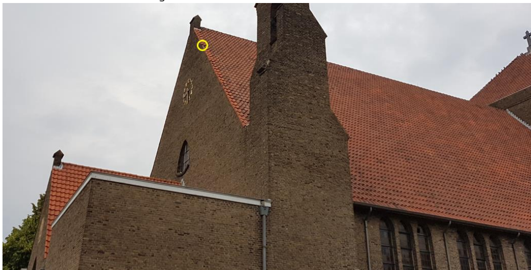
Foto 11. Nestlocatie van gierzwaluw onder het dak van de kerk
