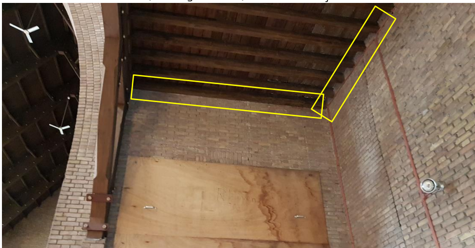
Foto 1. Voorbeeld van een van de verblijfplaatsen van vleermuizen tussen stenen gevel en houten balken (binnen gele kaders) aan de binnenzijde van de Sint-Jozefkerk
