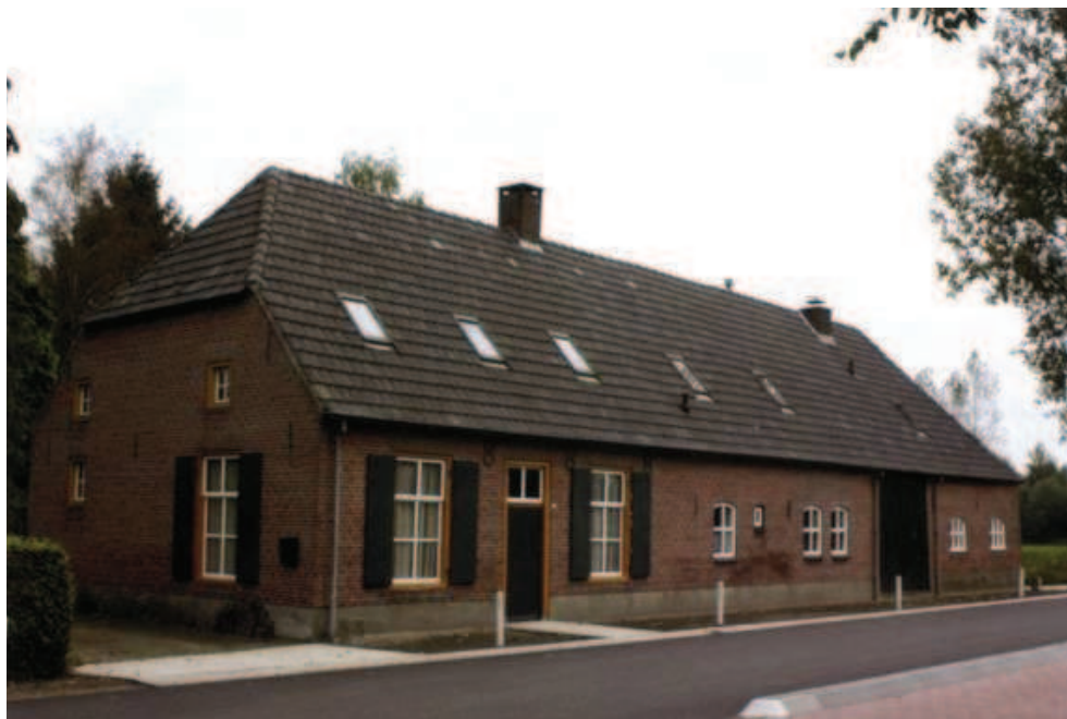
Langgevelboerderij uit 1888 aan de Oude rijksweg te Liempde
