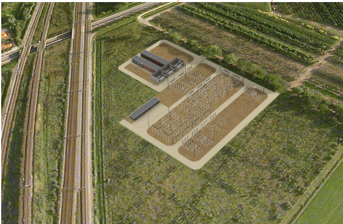
Afbeelding 2 Locatie nieuw hoogspanningstation Boxtel, fase twee
