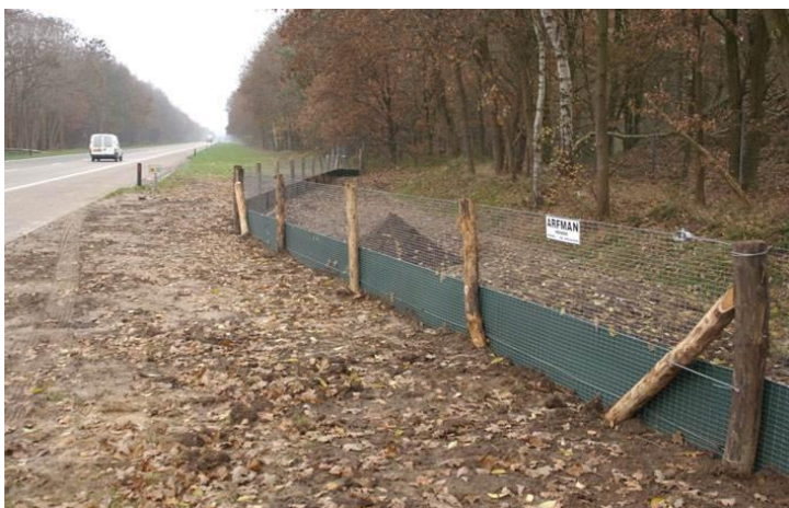
Figuur 11. Voorbeeld wildraster gecombineerd met amfibieënscherm.
