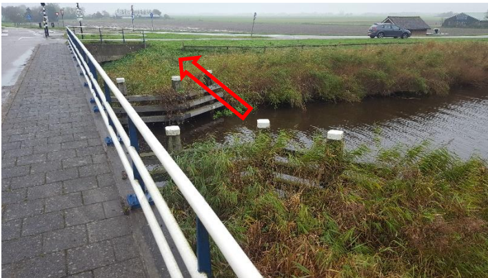
Figuur 12. Wildraster sluit niet aan op de faunapassage.
