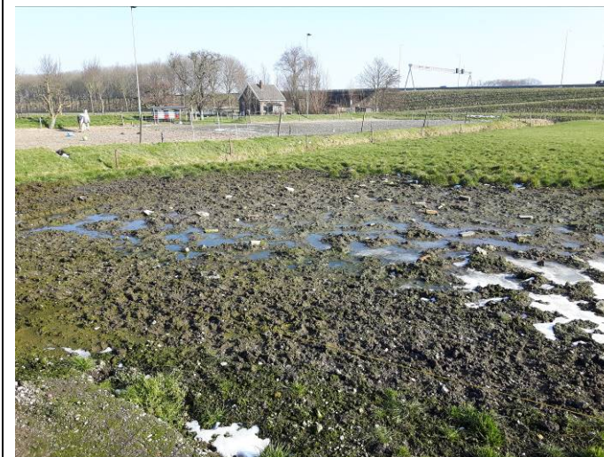
Foto 9: Puin op maaiveld uitloop dam 1
