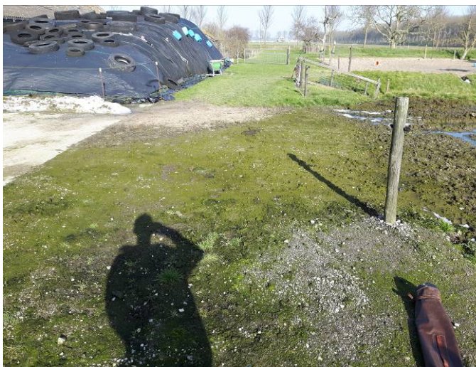
Foto 8: Opgebrachte slakkenlaag dam 1
