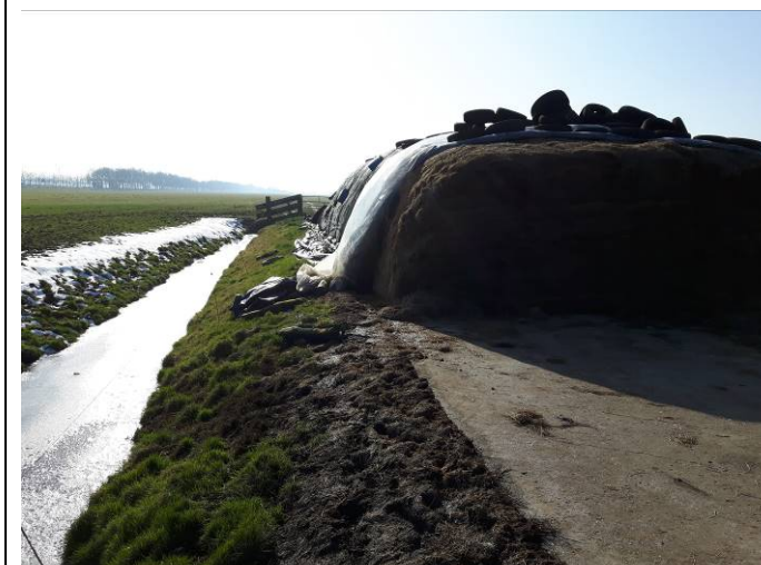
Foto 18: Betonpad en deel van gedempte watergang
