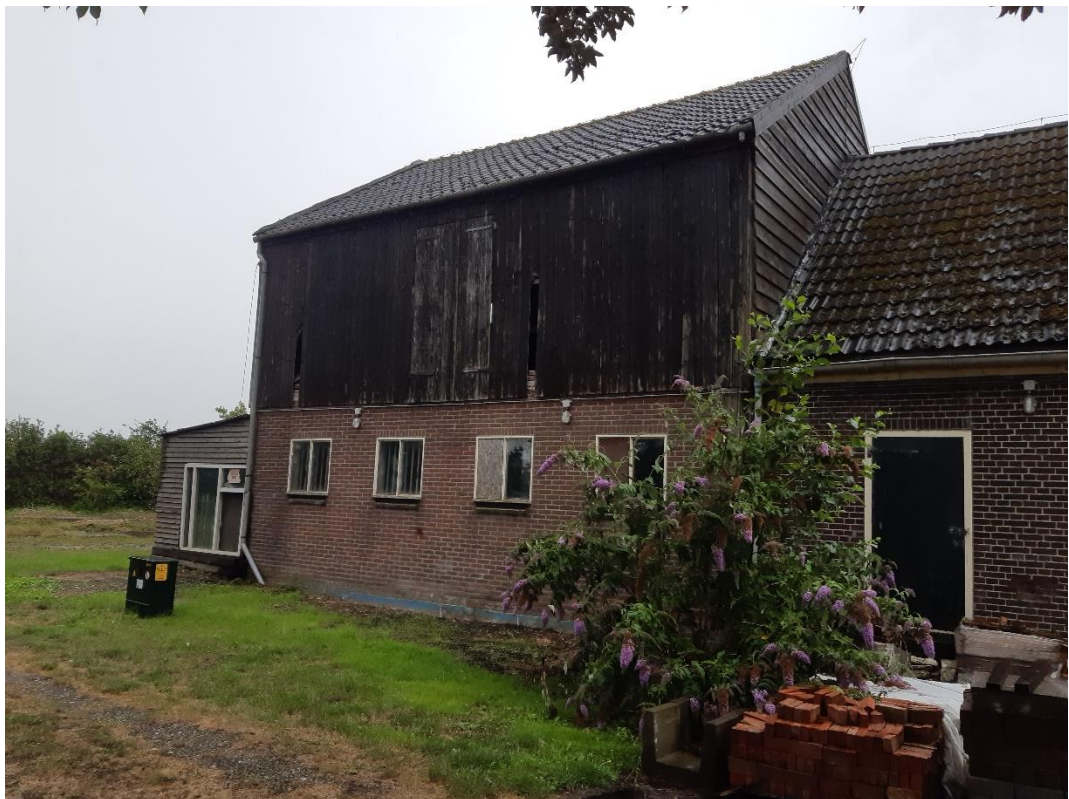
Te slopen bijgebouw
