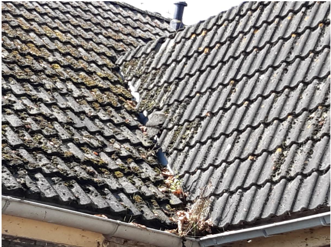
Dak van de woonboerderij
