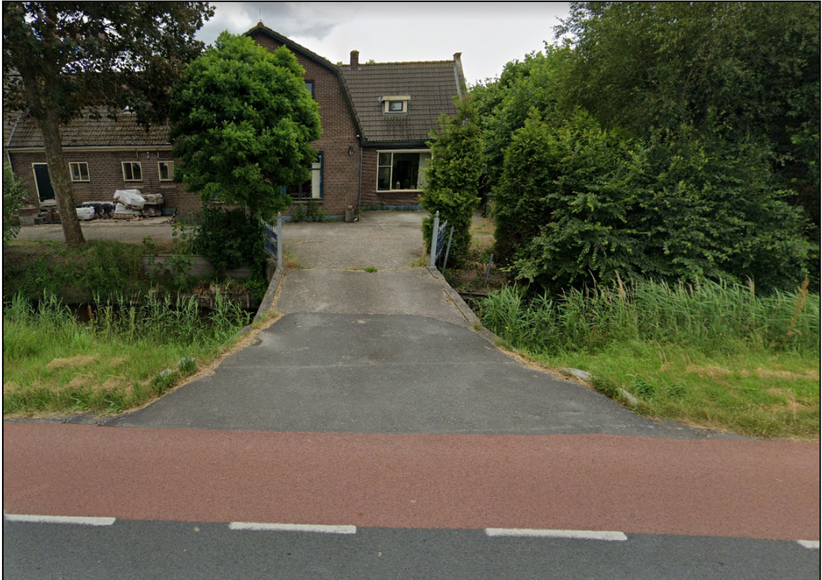
Figuur 3: Toegangsbrug Oosthuizerweg 72 in de huidige situatie
