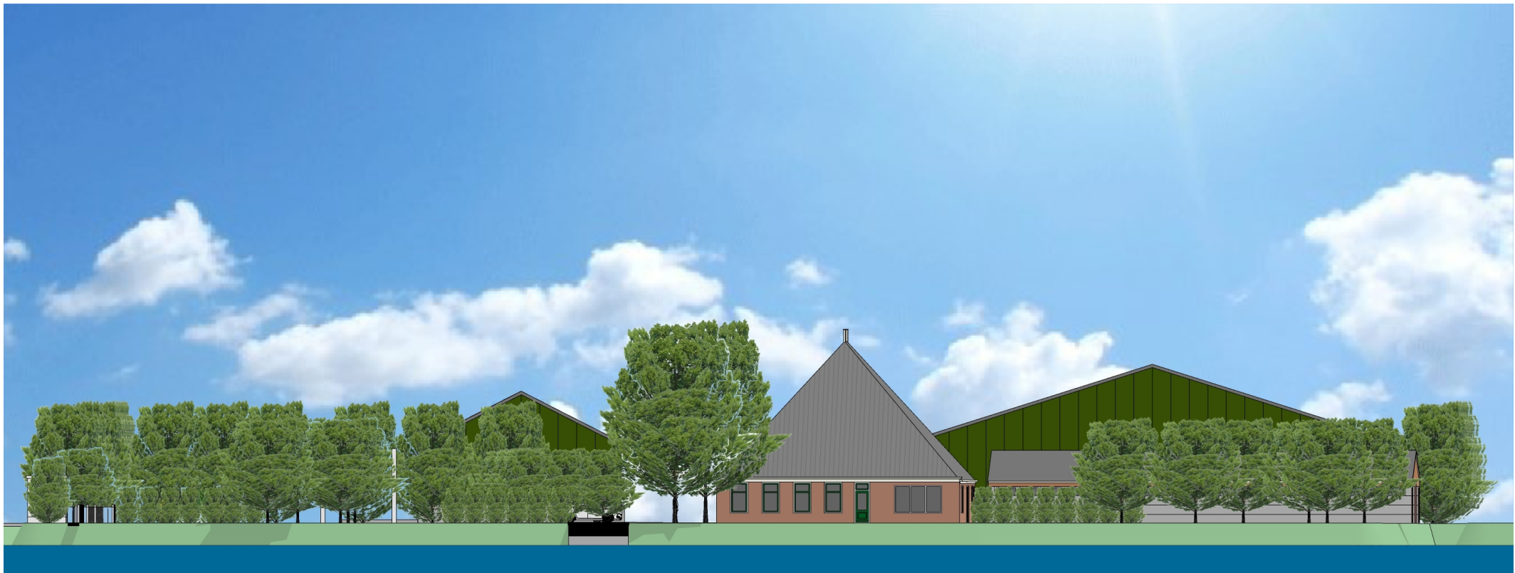
Brug (toegang tot perceel)
