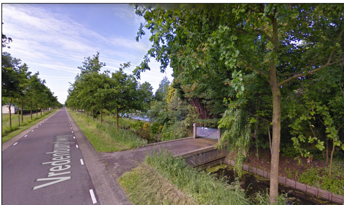
Figuur 2.1: Vredenburgweg in Beemster, gezien vanuit noordelijke richting, met de ontsluiting van perceel D-3097
