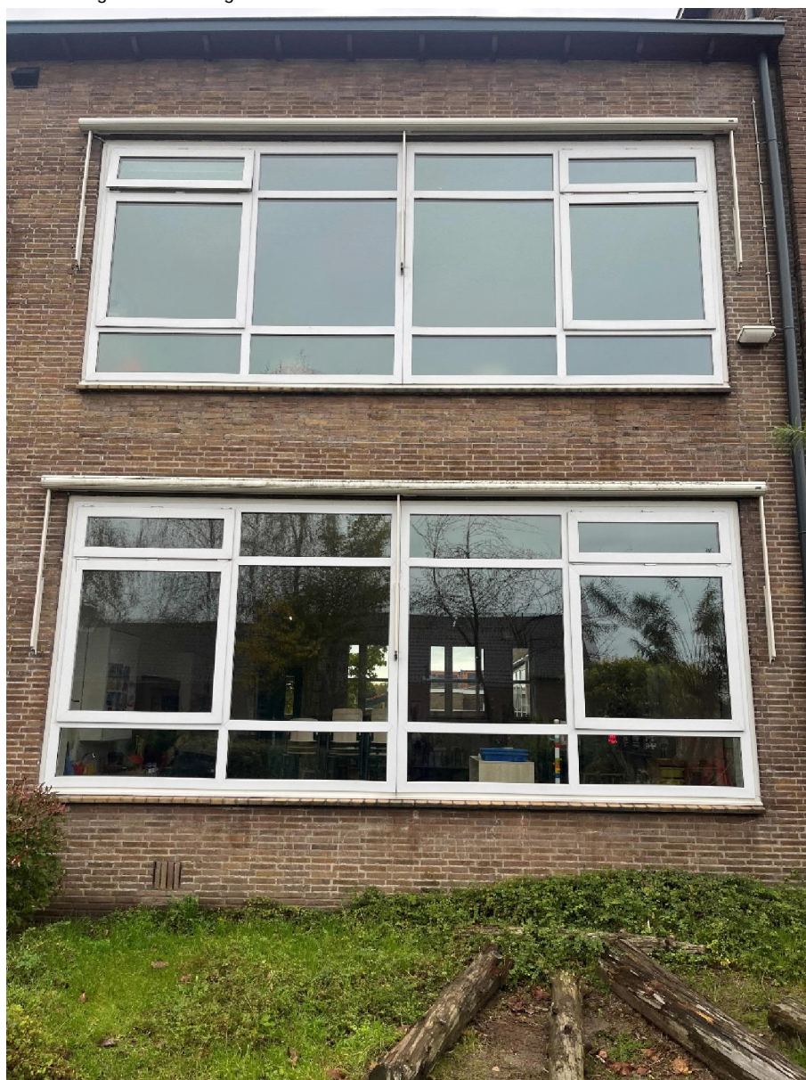
Afbeelding 5: Foto westgevel school
