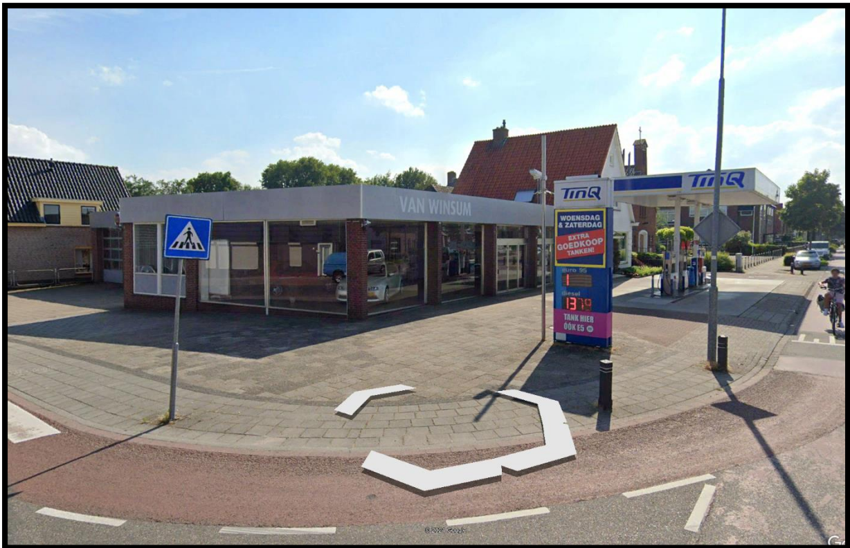
Het bestaande pand aan de Dorpsweg 23-25. Hoogte tussen 3-4 meter. (bron: Google Street View)
