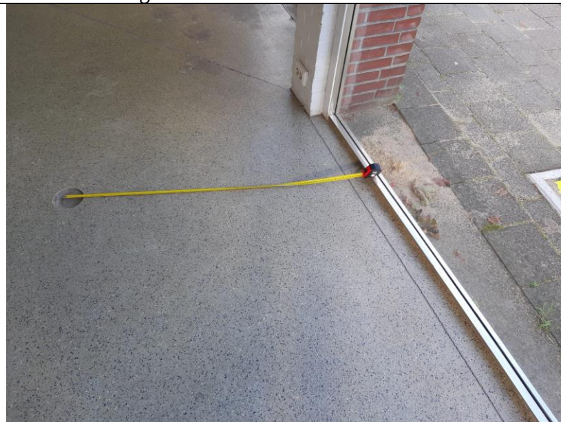
Foto 04 - boring 1017 en peilbuis 1018 (aanv. onderzoek)
