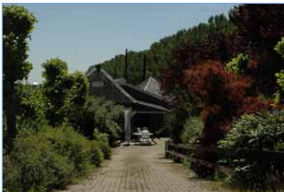
De groene entree vanaf de dijk. De schuur links wordt opgenomen in de nieuwbouw
