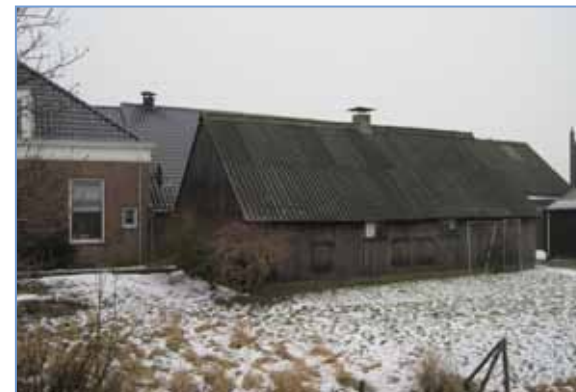
De houten schuur is erg mooi. Kan die niet verplaatst en geschikt gemaakt als woning ?
