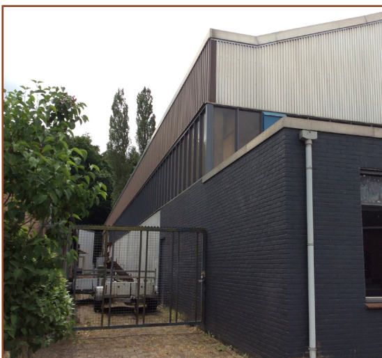
Afb. 2.6: Detail gevel bedrijfshal. Door de strakke afwerking en gebruikte materialen zijn er geen mogelijkheden voor vogels of vleermuizen.
