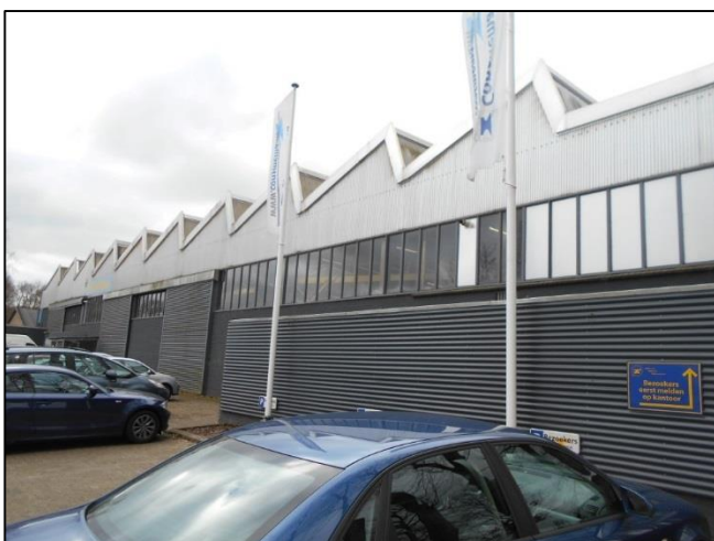
Foto 41: Sheddaken (asbestvrij)
