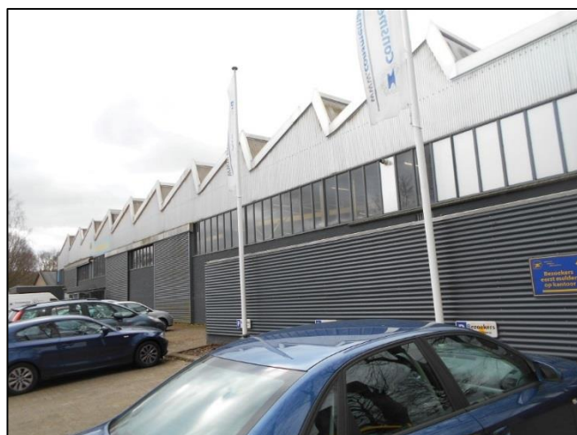
Foto 42: Sheddaken (asbestvrij)
