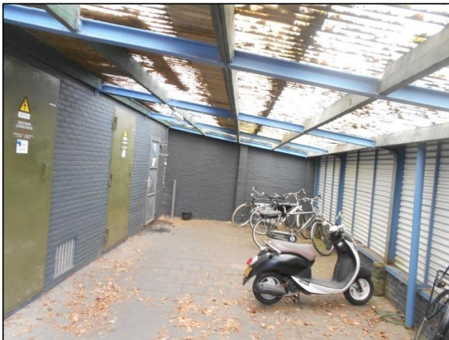
Foto 43: Traforuimtes (niet toegankelijk) en fietsenstalling
