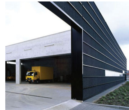
Afscheiding d.m.v. stalen spijlen
