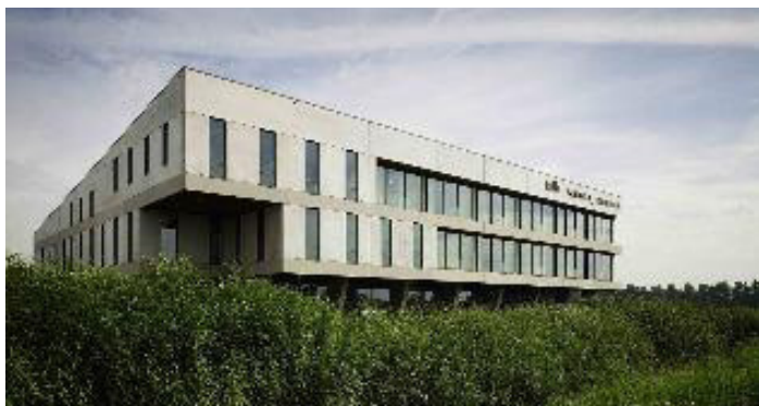
Open gevel naar de openbare ruimte
