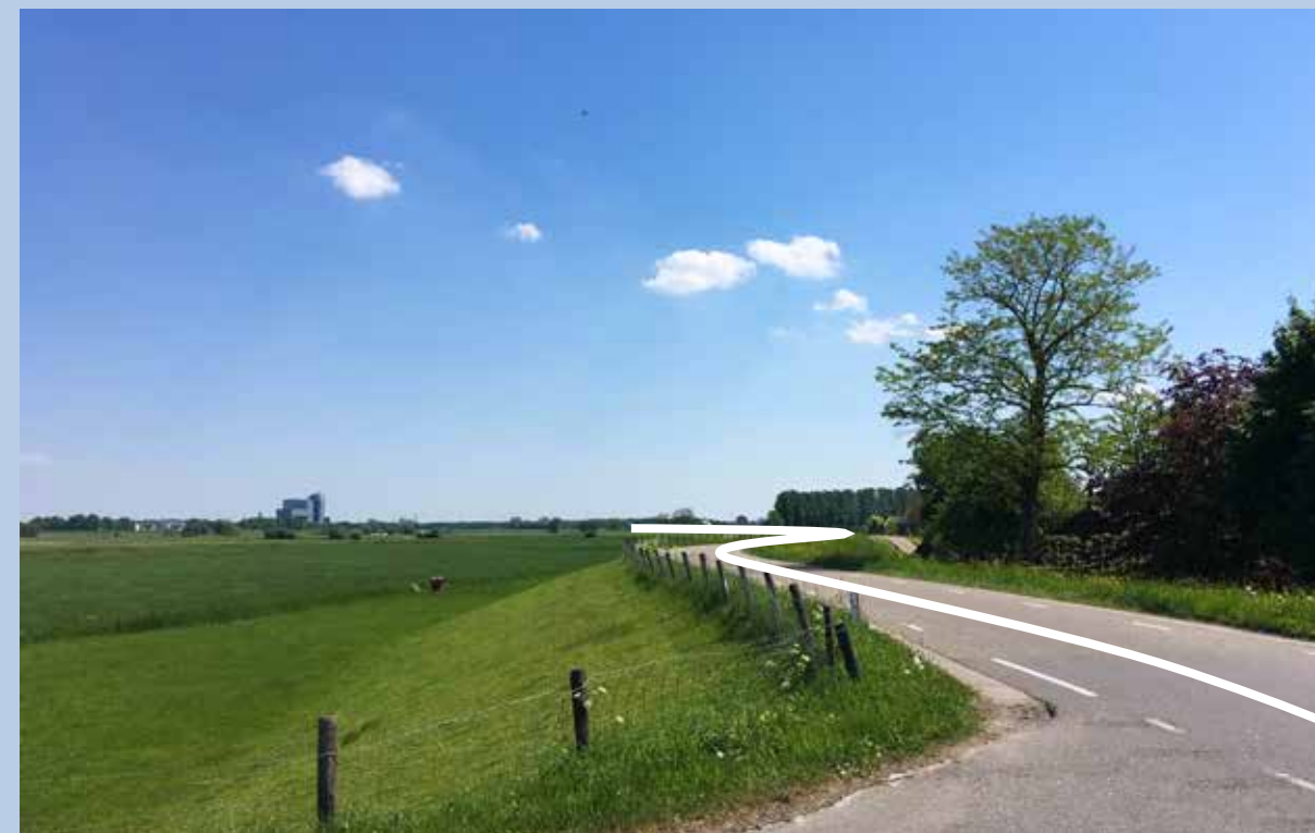
De Geldersedijk heeft een vloeiende loop en vormt de kering tussen de IJssel en het achterliggende land. De dijk heeft ook een waardevolle landschappelijke functie als fietsroute tussen Kampen en Hattem. Vanaf de dijk zijn er mooie doorzichten naar het achterland.
