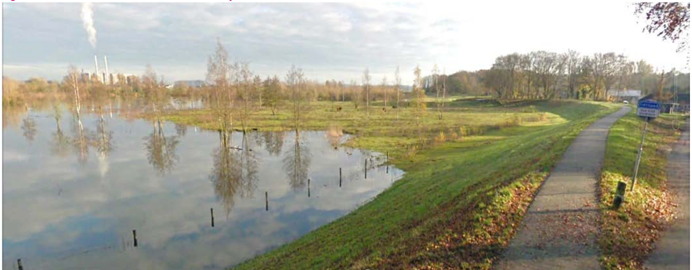
Figuur 6.9 Bestaande recreatieroute over de dijk
