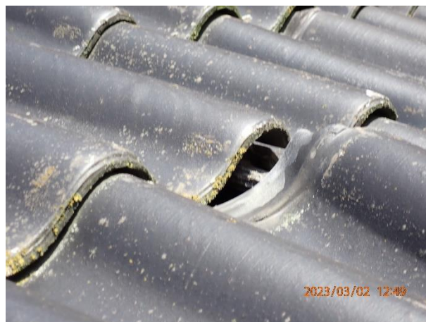
Foto 5: links, dit is een doorgestoken pijp waardoor ook ruimtes bij de muur ontstaan.
