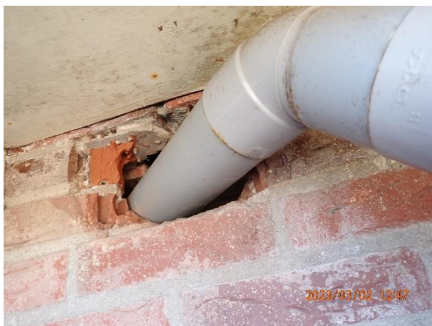
Foto 5: links, dit is een doorgestoken pijp waardoor ook ruimtes bij de muur ontstaan.
