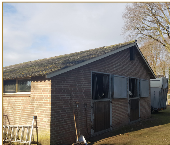
Afb. 2.2: Deel van het bijgebouw dat mogelijk gesloopt gaat worden in de toekomstige plannen. In het bijgebouw zijn nesten van de boerenzwaluw gevonden en hangt een nestkast.
