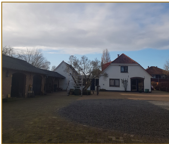
Afb. 2.1: Aanzicht op de oostkant van de bestaande woning en het erf. Dit deel zal behouden blijven.
