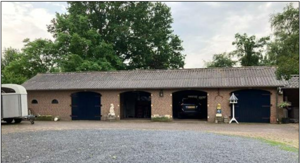
Bestaande paardenstallen op het verharde achtererf.
