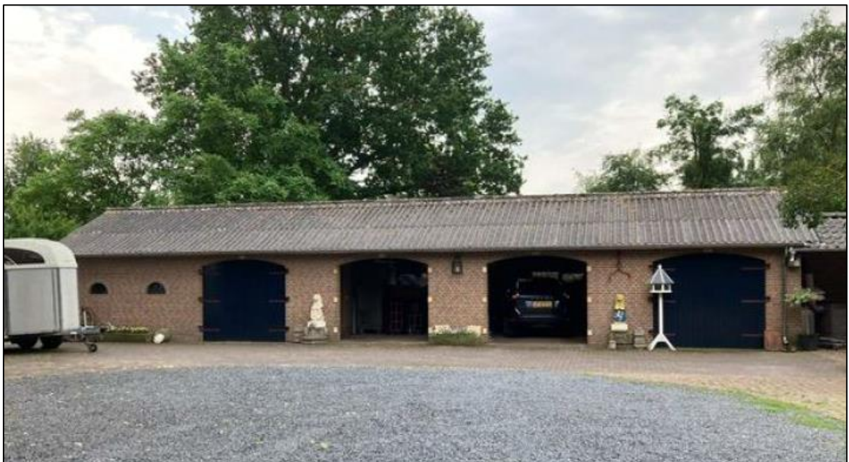
Bestaande paardenstallen op het verharde achtererf.
