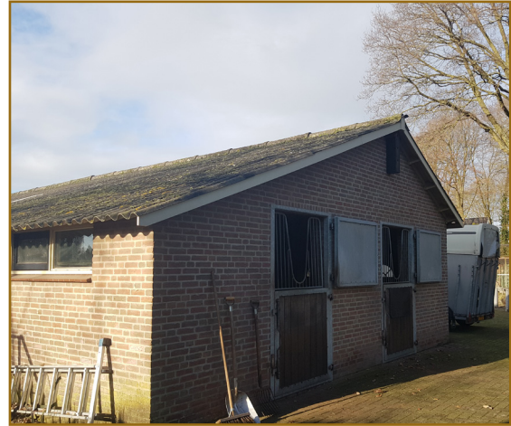
Afb. 2.2: Deel van het bijgebouw dat mogelijk gesloopt gaat worden in de toekomstige plannen. In het bijgebouw zijn nesten van de boerenzwaluw gevonden en hangt een nestkast.
