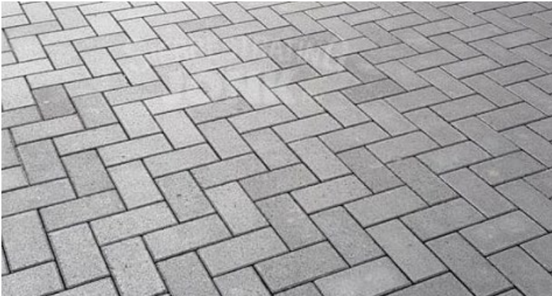
Grijze klinkers Betonklinkers in visgraatverband
