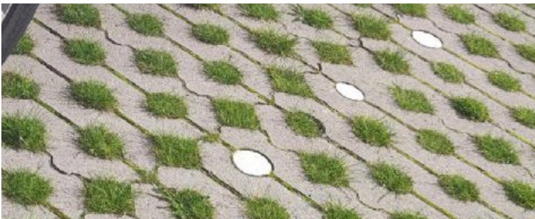
Grasbeton met markering parkeerplaatsen referentie MBI
