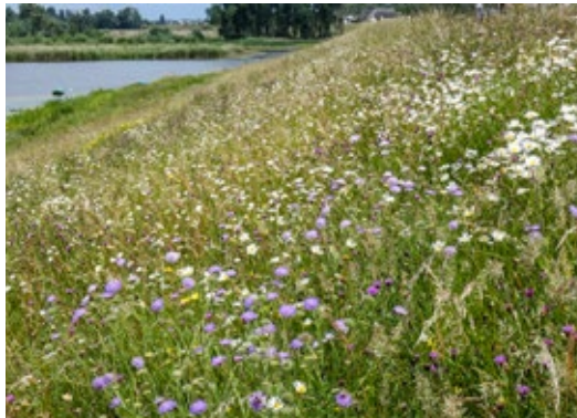
Talud bestaande uit een bloemrijke weide
