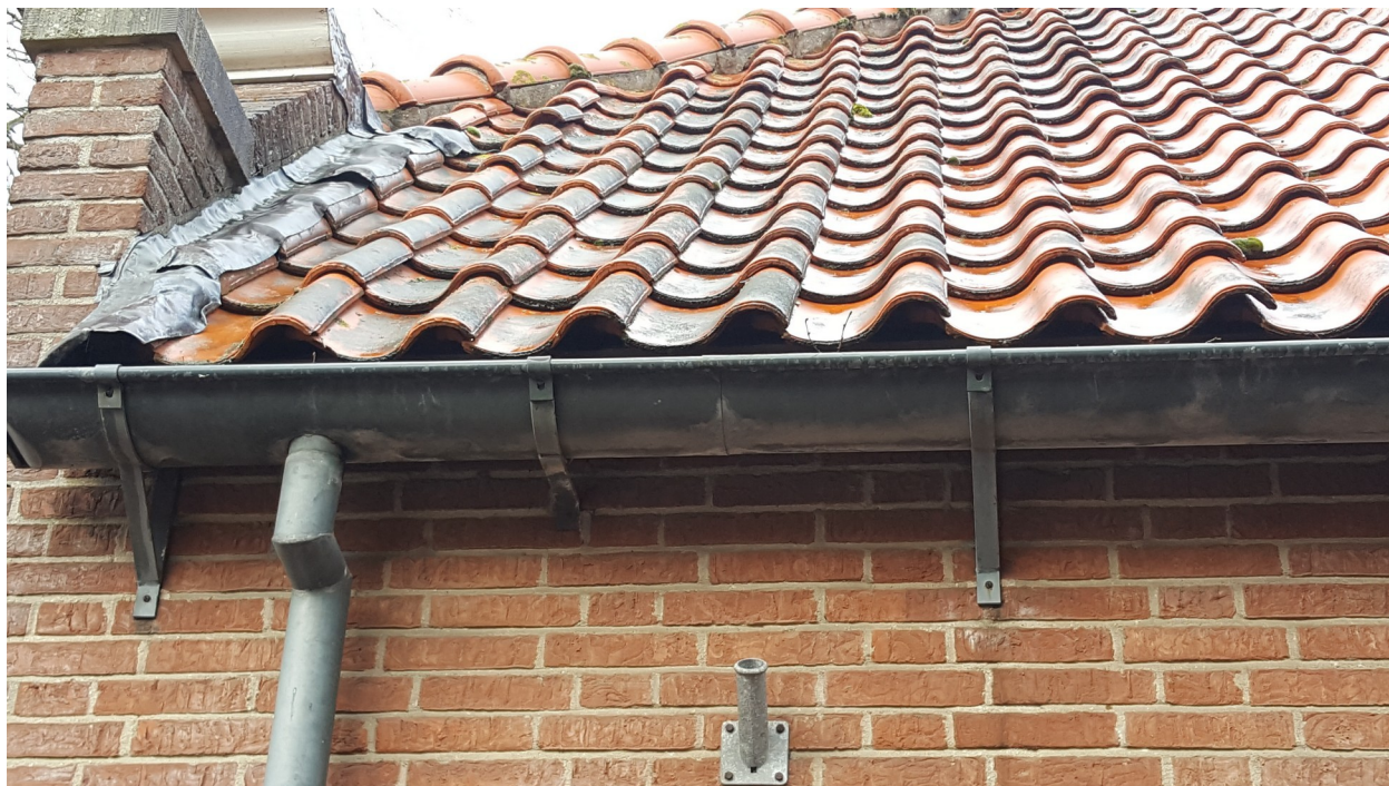
Onder de dakpannen boven de dakgoot zijn er geschikte ruimtes aanwezig voor nestplaatsen van huismus. Foto. B. Verhoeven | Ecoresult BV
