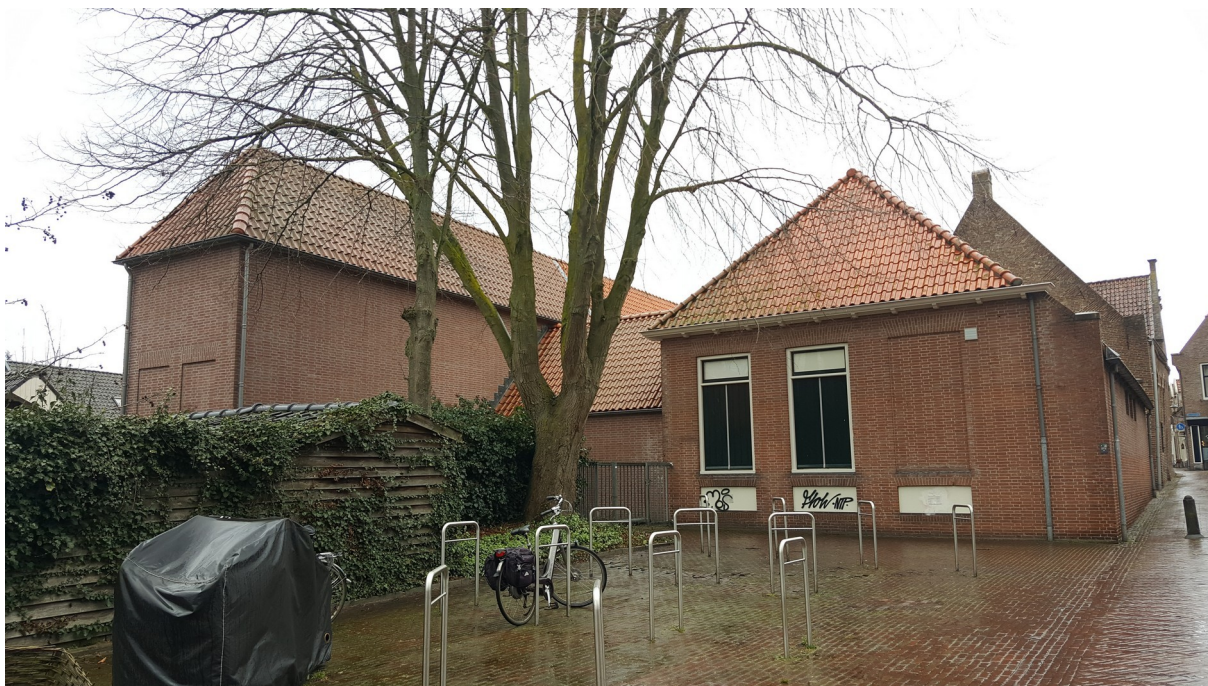
De aanbouwen aan de achterzijde van de panden. Deze uitbouwen zullen worden gesloopt. Hier komen nieuwe huizen / appartementen voor in de plaats. Foto. B. Verhoeven | Ecoresult BV
