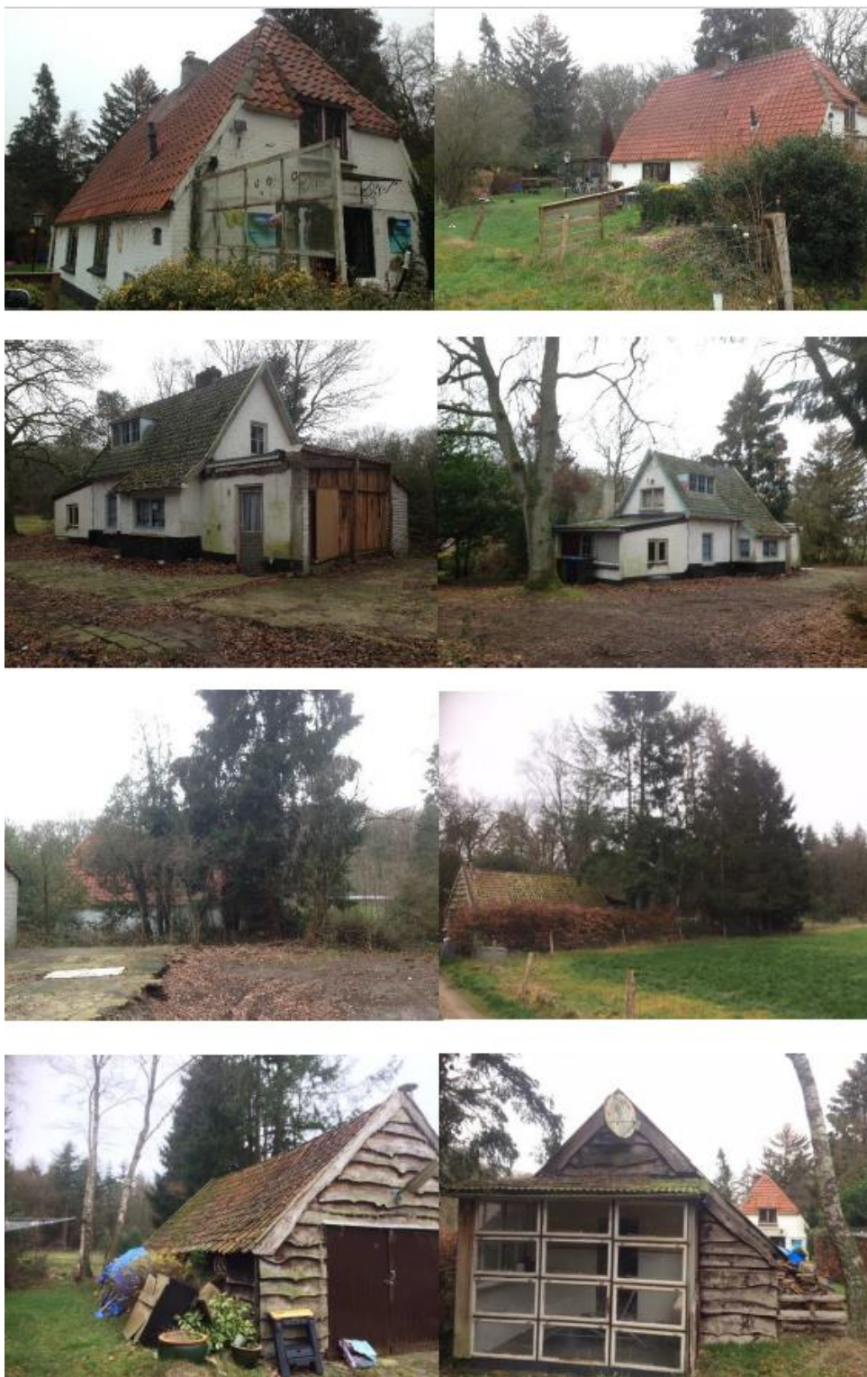
Afbeelding 3. Impressie plangebied met te slopen gebouwen en te verwijderen beplanting. Het betreft een weergave van 10 januari 2019 (bron: toetsing Wet natuurbescherming, Eelerwoude 2019).
