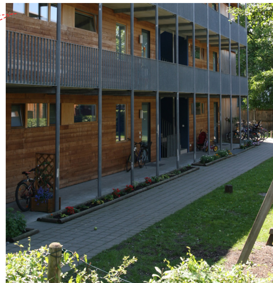
Vriendelijke galerijgevel, gevelopeningen op maaiveldniveau
