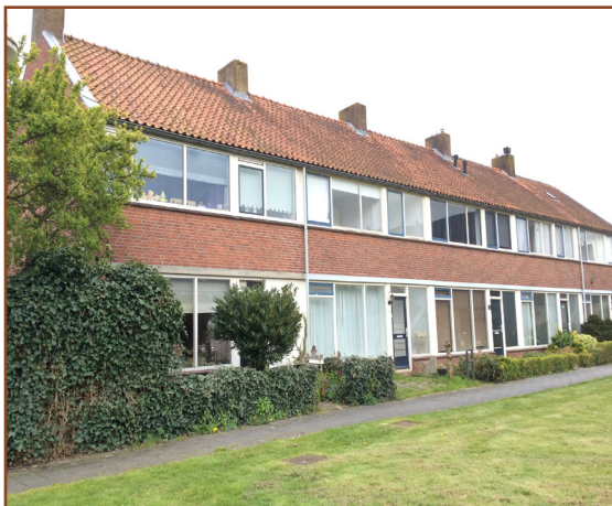
Afb. 1.3 Beeld van de gevels (oostzijde cluster 520000)
