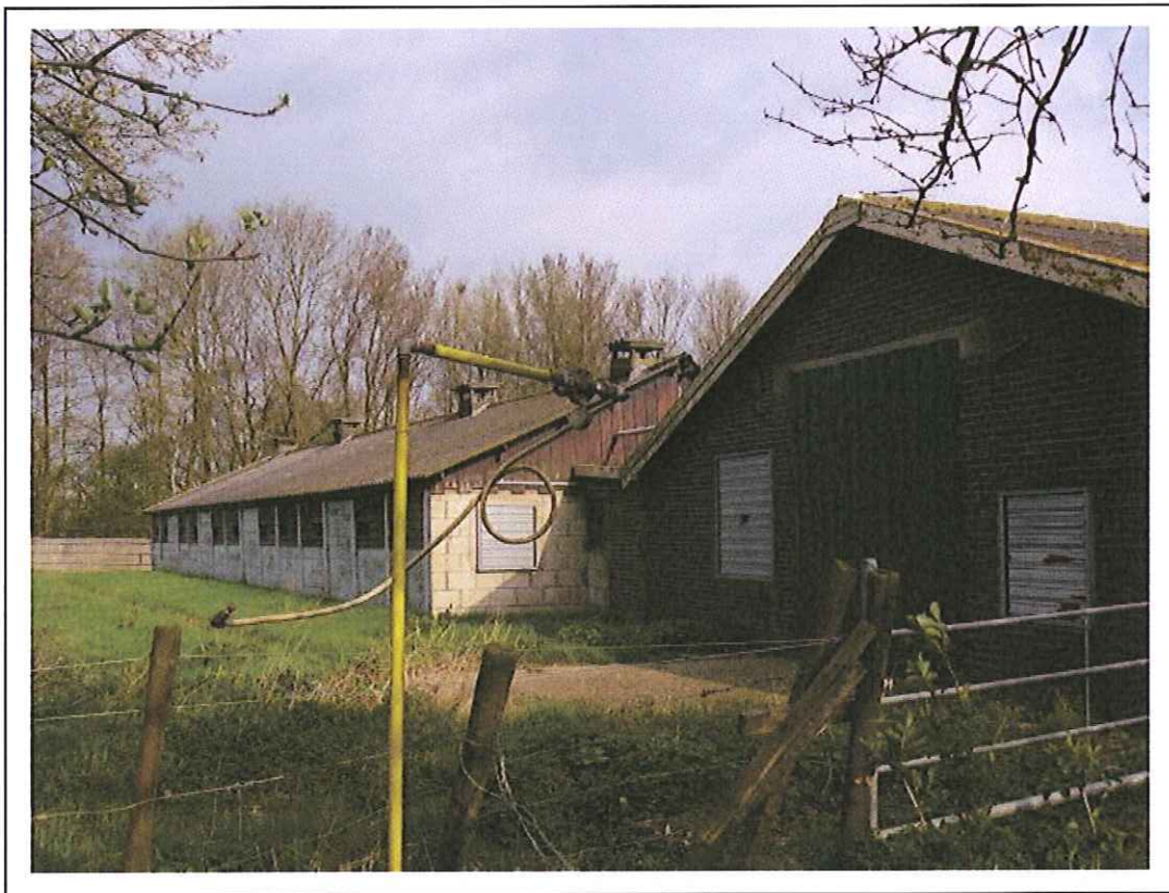
Foto 1. te slopen kippenchuren
