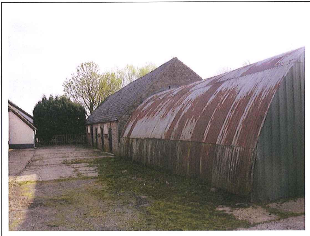
Foto 2. te slopen romneyloods en oude veestal
