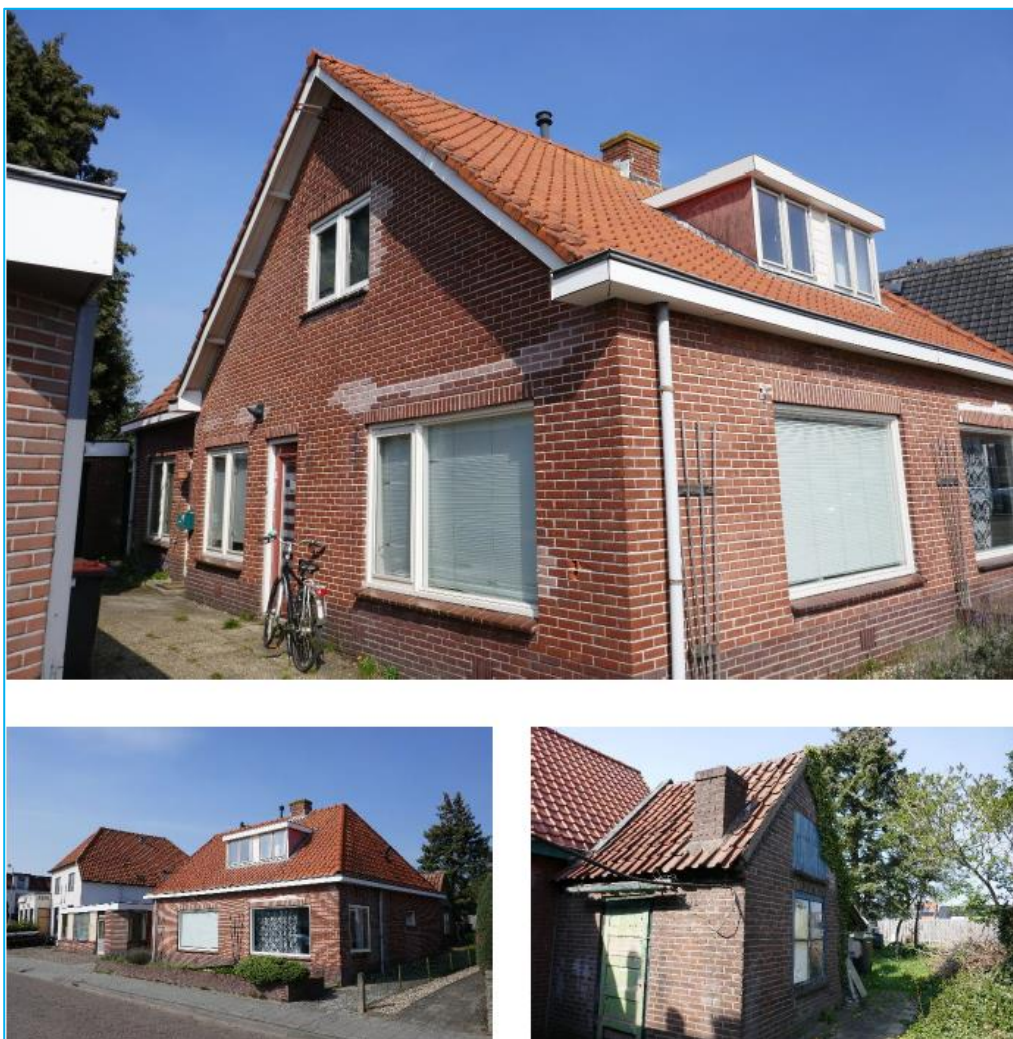
Te slopen bebouwing op het perceel Allee 1, 1a en 3
