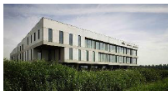
Open gevel naar de openbare ruimte
